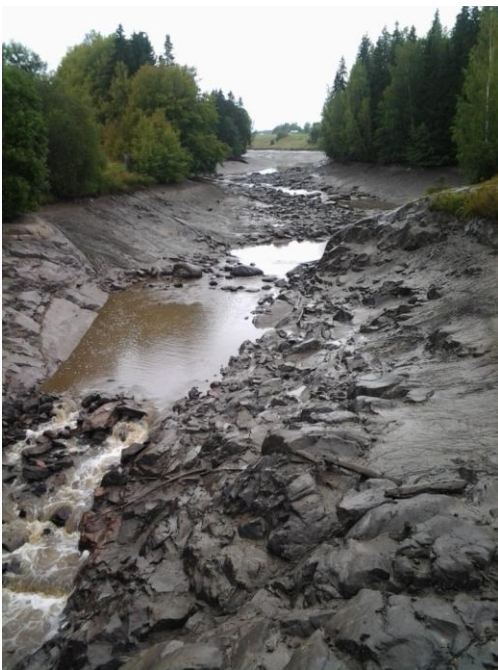
Kuva3. Vahingon jälkeen näkymä 0,5 km Juntolan padolta ylävirtaan.
