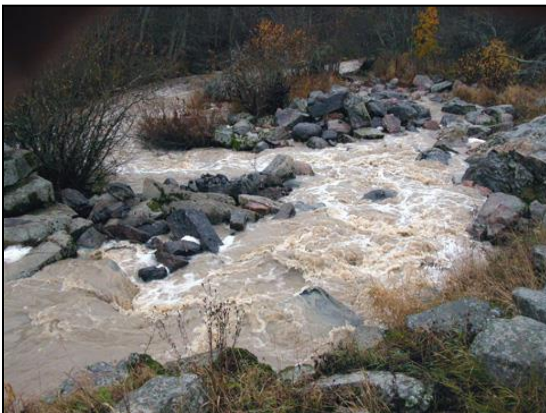
Kuva 4 Kalatie ylhäältä kuvattuna rakentamisen jälkeen
