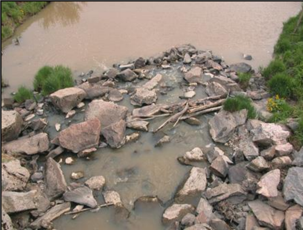
Kuva 5 Kivikkoa sillan päältä kuvattuna
