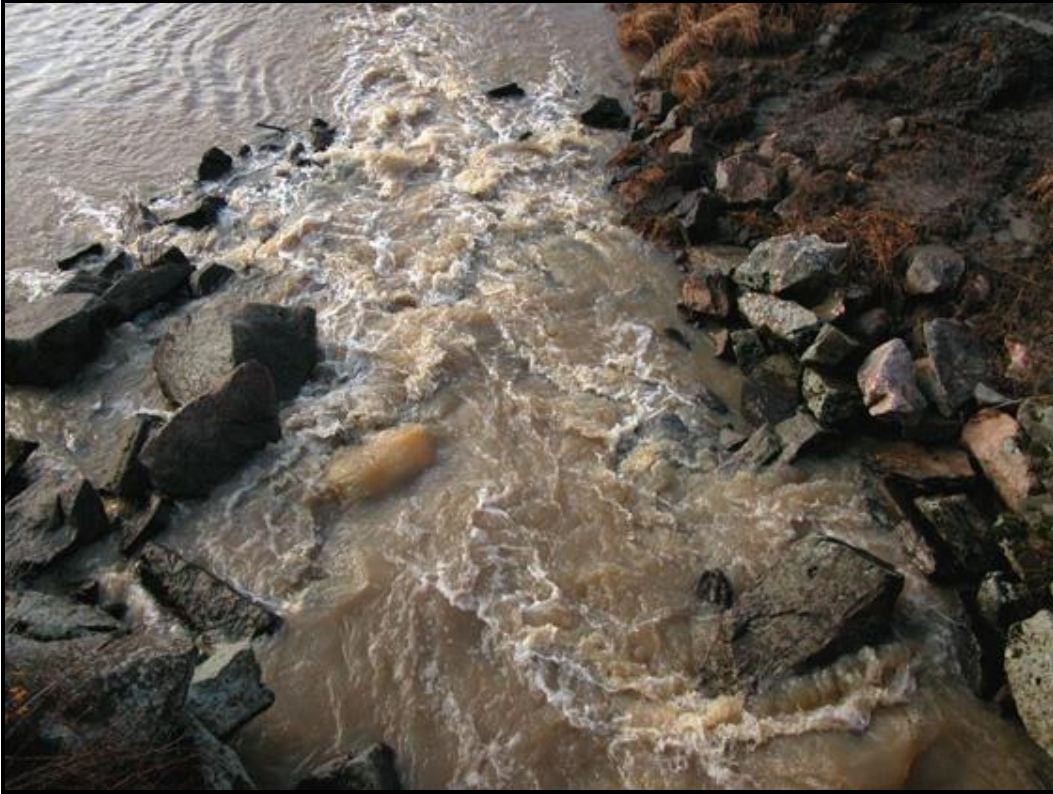
Kuva 7 Kivikkoon muodostettiin selkeä nousu-uoma
