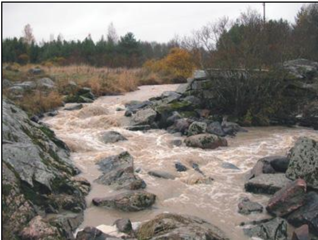
Kuva 3 Myllypadon sortunut osa kalatien rakentamisen jälkeen
