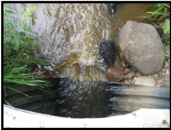
Kuva 17. Hallinojan ylempi nousueste on tierummun ala- puolinen pudotus.
