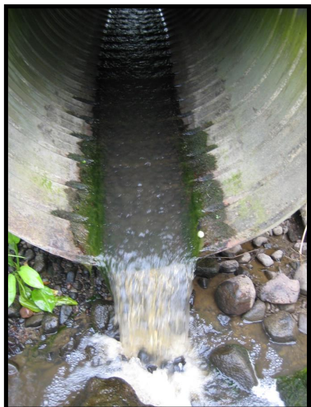
Kuva 23. Lapinolan yläosissa sijaitseva kiviröykkiö muodostaa luonnollisen kulkuesteen. Kuva 24. Lapinolan alaosan tierummun pudotus muodostaa kulkuesteen.
