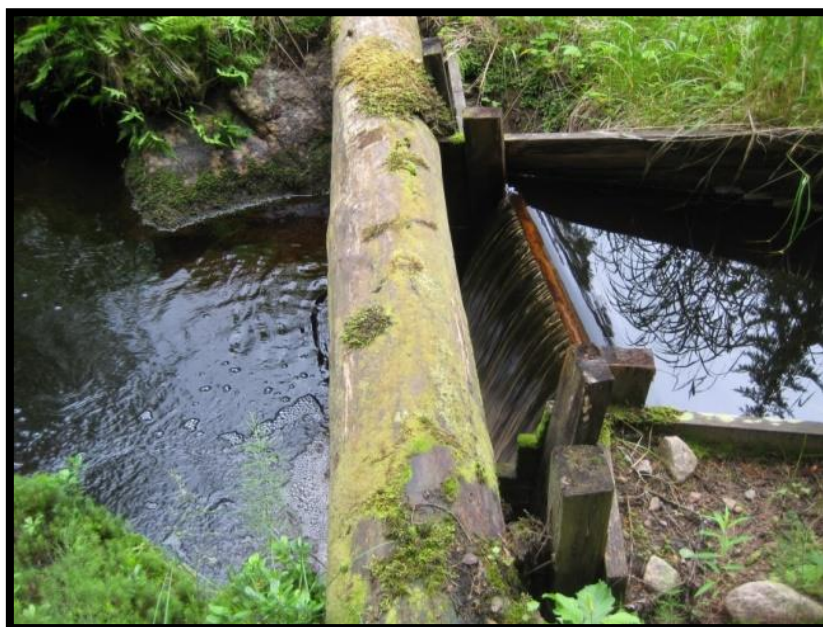
Kuva 29. Hallahuhdanoja on valjastettu koko uoman leveydeltään vedenottoon lampea varten.
