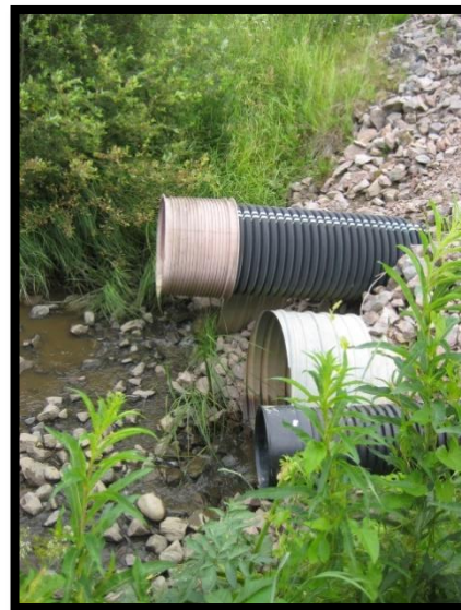
Kuva 18. Hallinojan alemmassa kulkues- teessä on ylivirtaamia pyritty hillitse- mään usean putken avulla.
