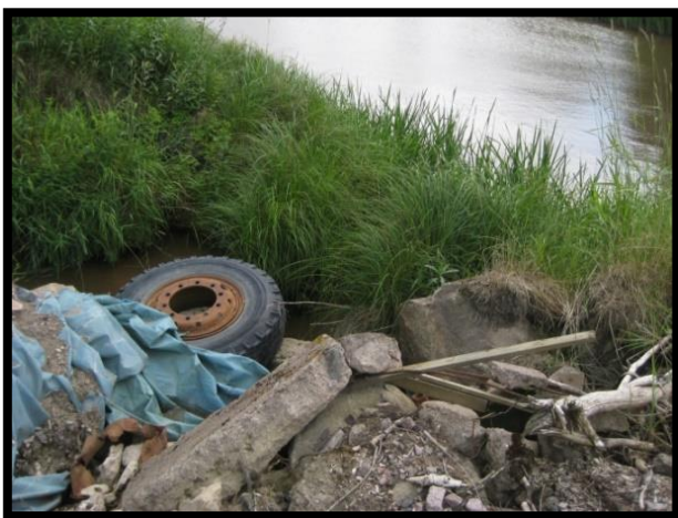
Kuva 20. Lapinojan pohjapato on muodostettu romusta.
