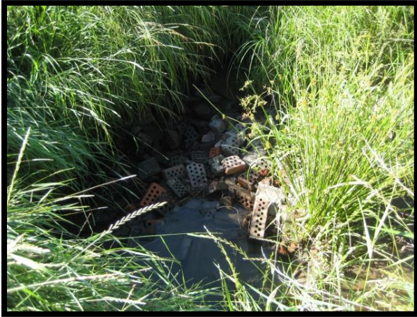
Kuva 15. Holmanojan tiilistä muodostettu alempi estekoh- ta.
