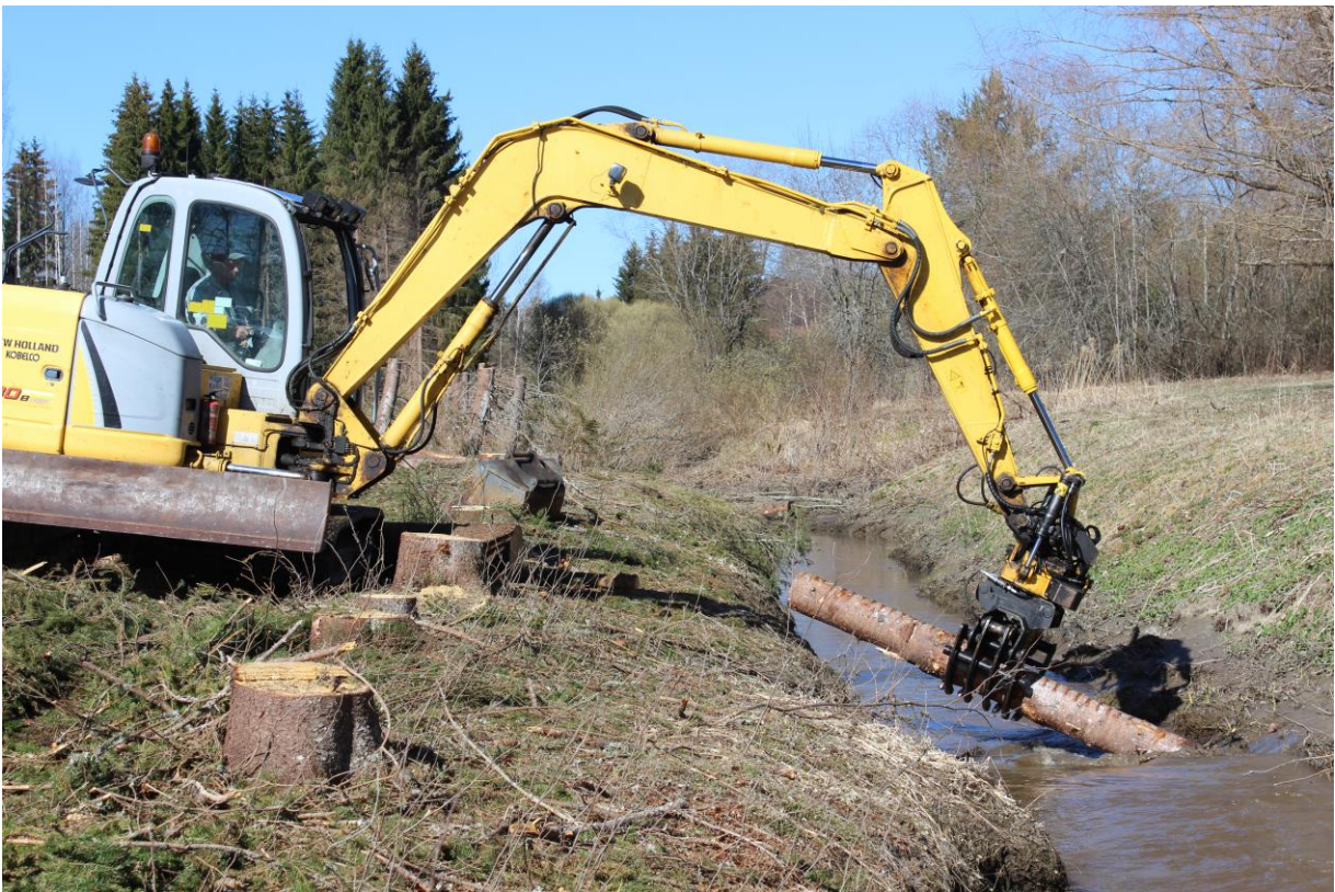
Kuva 14. Karhunojaan lisättiin suurikokoista puuta monimuotoistamaan uomaa.
