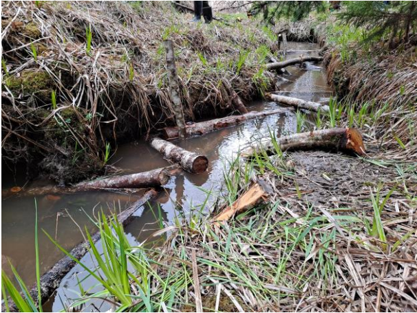
Kuva 12. Preitilämpuroon tehtiin talkoilla puukunnostuksia keväällä 2022. Osa puista hakattiin puopenkkaan kiinni, jotta virta ei niitä kuljettaisi. Kuva 13. Karhunojalla järjestettiin kunnostustalkoot, joissa kivettiin ja soraistettiin puroa.
