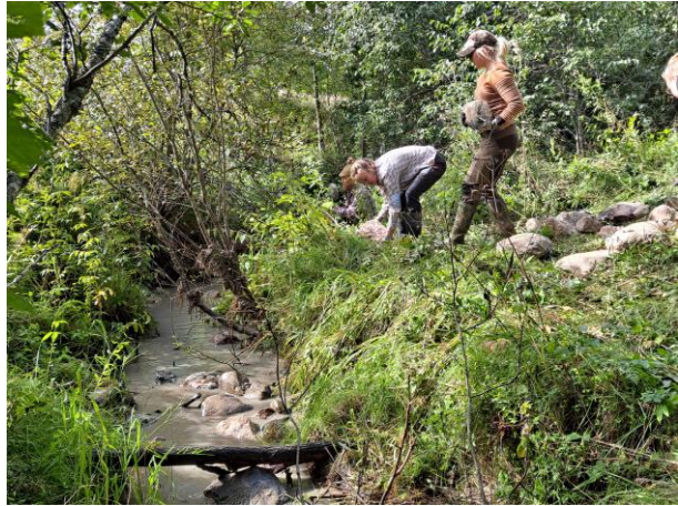
Kuva 12. Preitilämpuroon tehtiin talkoilla puukunnostuksia keväällä 2022. Osa puista hakattiin puopenkkaan kiinni, jotta virta ei niitä kuljettaisi. Kuva 13. Karhunojalla järjestettiin kunnostustalkoot, joissa kivettiin ja soraistettiin puroa.
