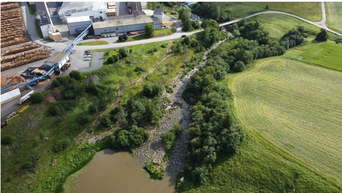
Kuva 4 Koivukylänkoski kunnostusten jälkeen. Kuva Pasi Lahtinen.
