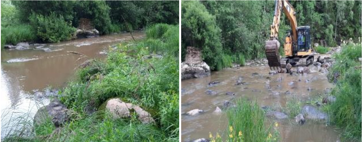
Kuvat 3 ja 4. Koskenpääkosken niska-alueita ennen (kuva 3 vas.) ja jälkeen (kuva 4 oik.) uoman muokkaamista
