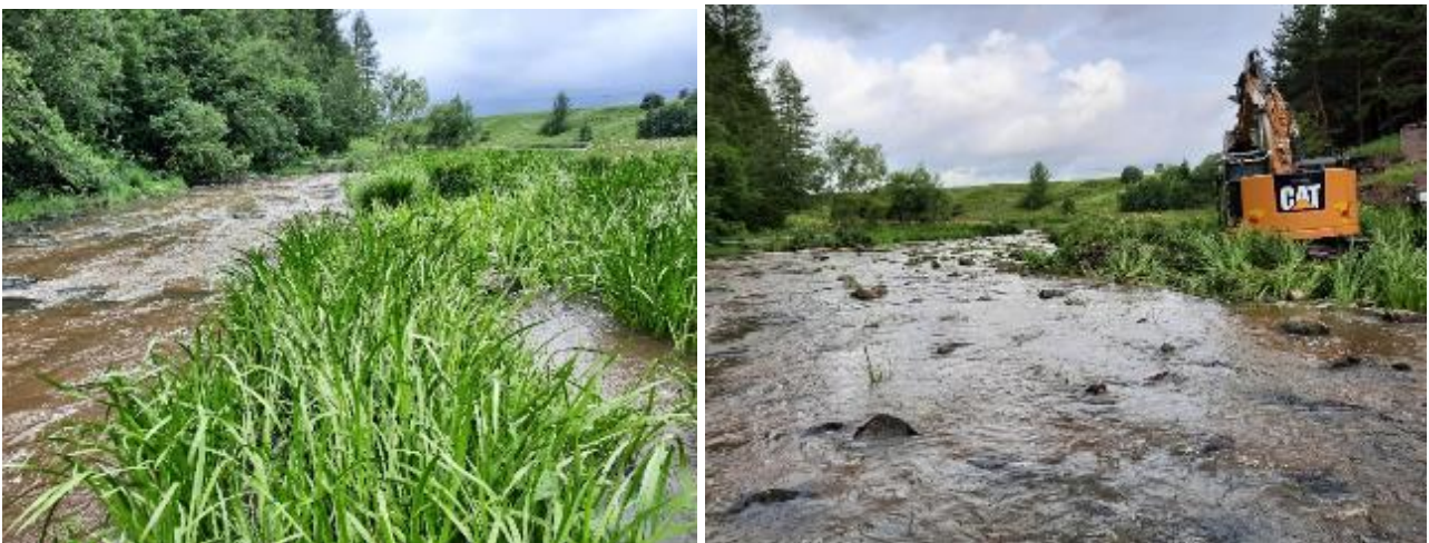
Kuvat 7 ja 8. Eurankosken alempi perkuukiviriutta (kuva 7 vas.) ja riutan purkua (kuva 8 oik.).
