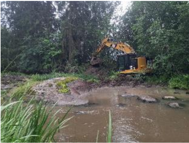
Kuvat 28 ja 29. Kärjäkosken yläosaa muotoiltiin niin sivu- (kuva 28 vas.) kuin päähaaraakin (kuva 29 oik.) tukkivan kasvuston poistolla ja sen alta paljastuneita kiviä siirrellen
