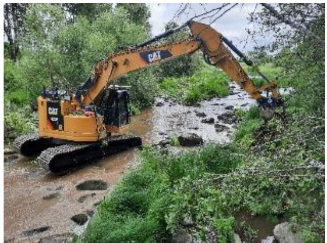
Kuvat 17 ja 18. Krouvinkosken yläosalle tehtiin kaksi soraikkoa, josta laajempi sijoittui pääuomaan (kuva 17 vas.), jonka jälkeen soraikon alapuolista uomaa monimuotoistettiin pienpoikasille sopivaksi (kuva 18 oik.).
