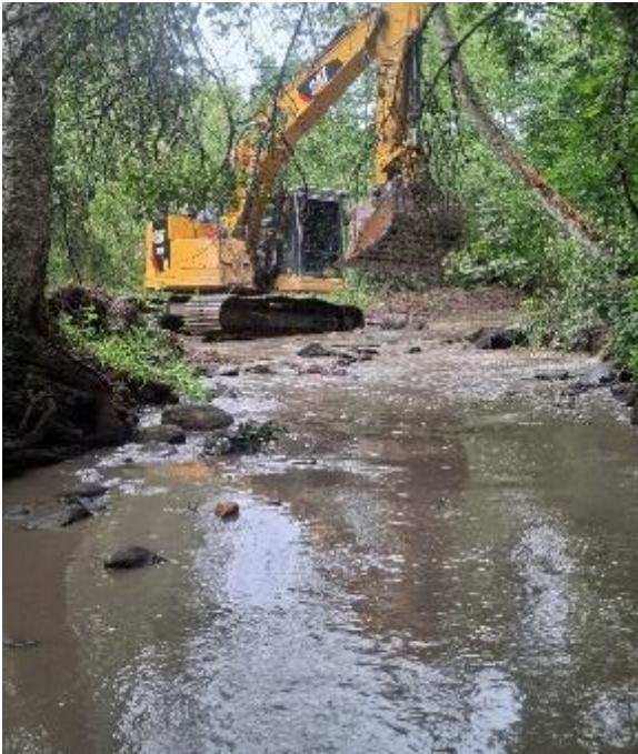
Kuva 32. Karjakosken sivuhaaraan luotiin kaksi soraikkoa, toinen koneen yläpuoliseen haaran osaan ja toinen koneen alapuolella olevien kivien suojaan
