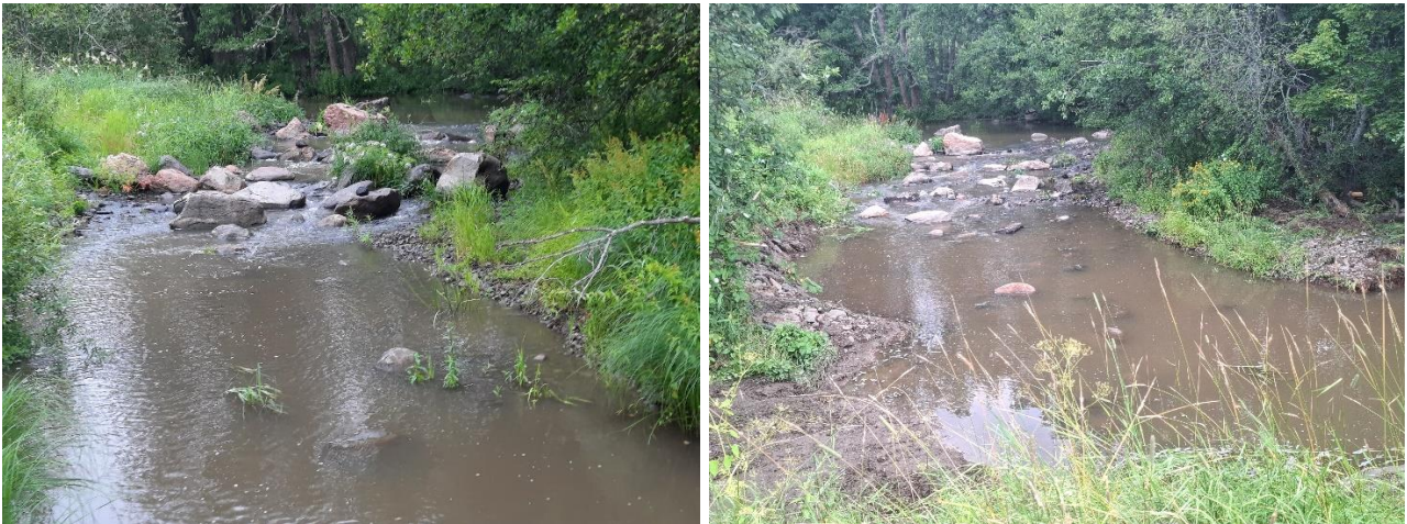
Kuvat 35 ja 36. Tuimalankosken vahvasti kynnystettyä uomaa (kuva 33 vas.) muotoiltiin siten, että siitä muodostui koskimaisempi (kuva 34 oik.) ja kosken alapuolelle uoman vasempaan reunaan tehtiin soraikko
