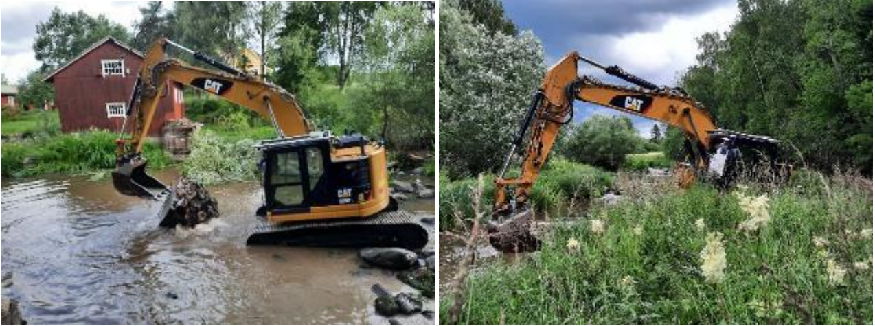
Kuvat 19 ja 20. Krouvinkosken myllyn kohdalla poistettiin suvannon keskeltä räjäytettyjä vaaraa aiheuttavia patorakenteita (kuva 19 vas.) ja purettiin ja muotoiltiin suvantoalueiden välissä olevien koskipaikkojen kasvistoisia perkuukivialueita avarammiksi koski- ja niva-alueiksi (kuva 20 oik.).
