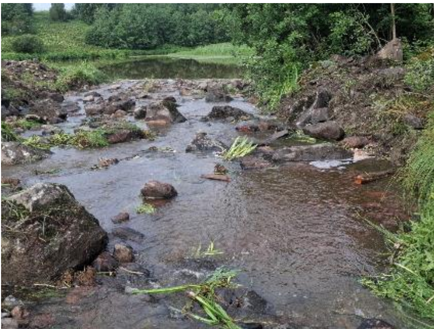
Kuva 27. Koivukylänkosken sivuhaara muokkauksen ja soraikoiden perustamisen jälkeen (vrt kuva 23)
