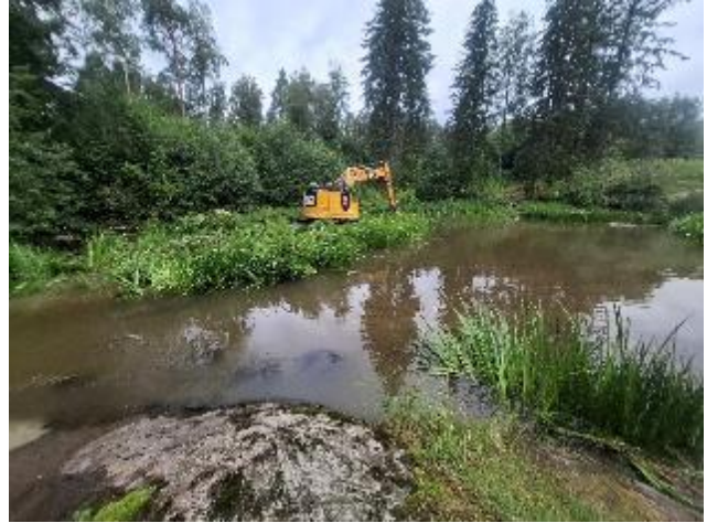
Kuvat 28 ja 29. Kärjäkosken yläosaa muotoiltiin niin sivu- (kuva 28 vas.) kuin päähaaraakin (kuva 29 oik.) tukkivan kasvuston poistolla ja sen alta paljastuneita kiviä siirrellen
