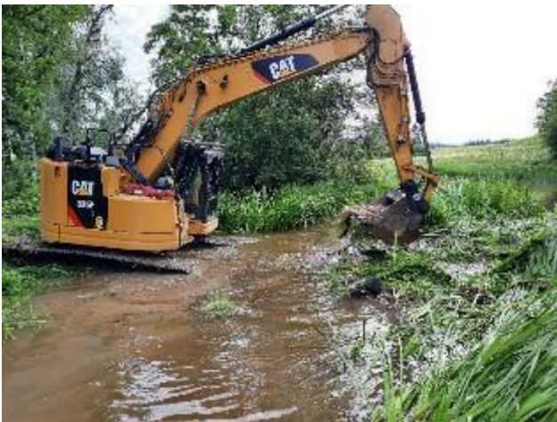
Kuvat 17 ja 18. Krouvinkosken yläosalle tehtiin kaksi soraikkoa, josta laajempi sijoittui pääuomaan (kuva 17 vas.), jonka jälkeen soraikon alapuolista uomaa monimuotoistettiin pienpoikasille sopivaksi (kuva 18 oik.).
