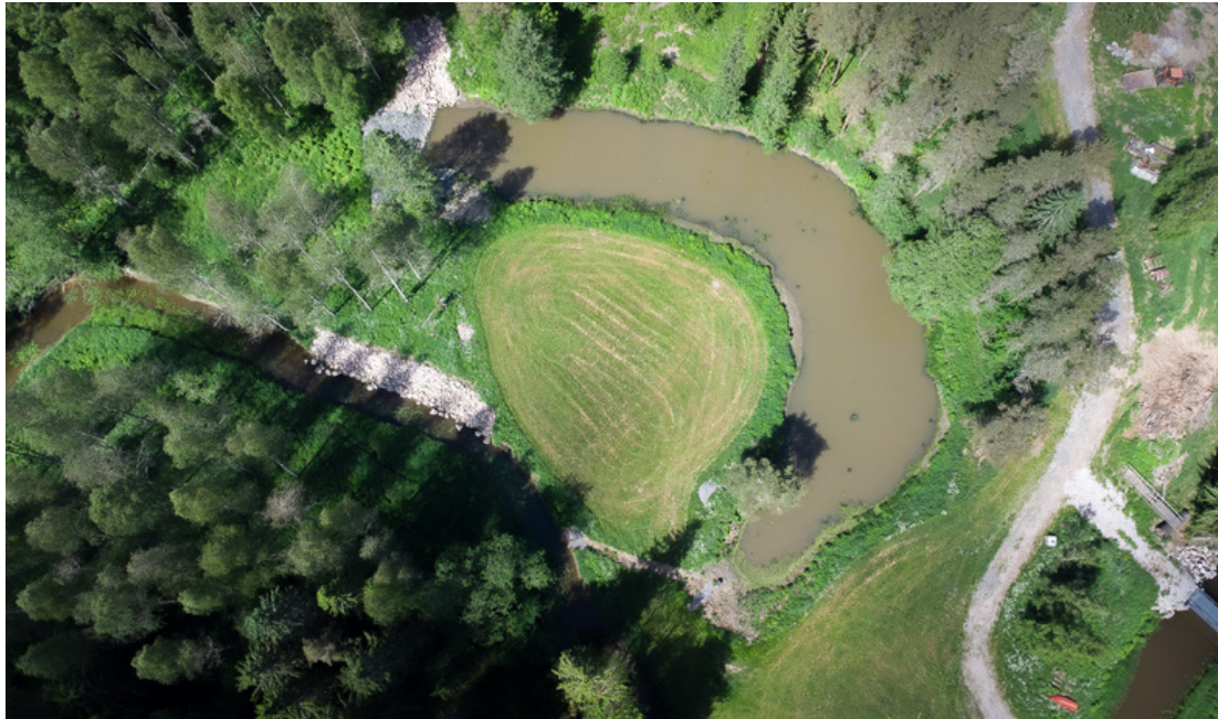
VALUTA3 -hankkeessa toteutettu kosteikkoallas ja uoman eroosiosuojaus. Kuva: Viljami Huhtala.
