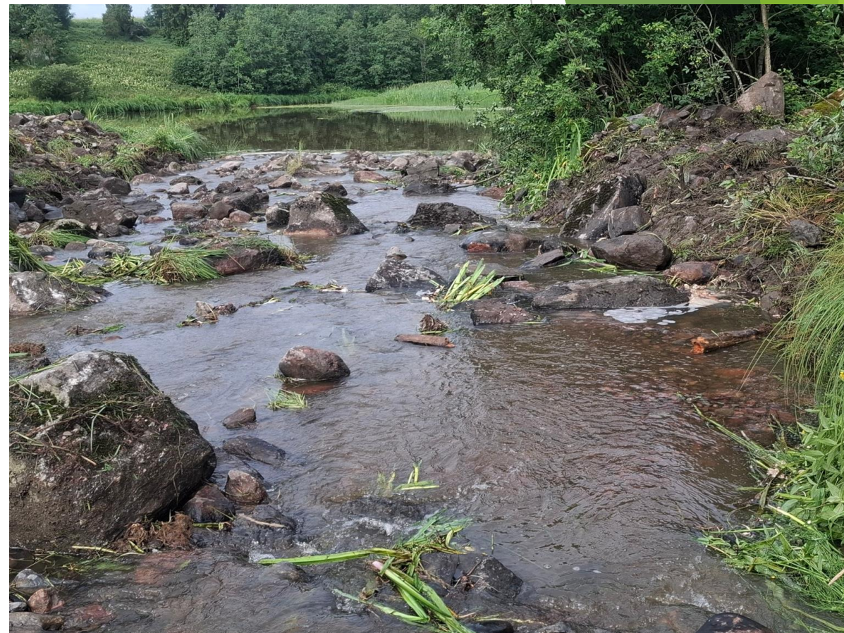
Koivukylänkosken sivuhaaraan, rannan tuntumaan, tehtiin lohkareiden suojaama soraikko
