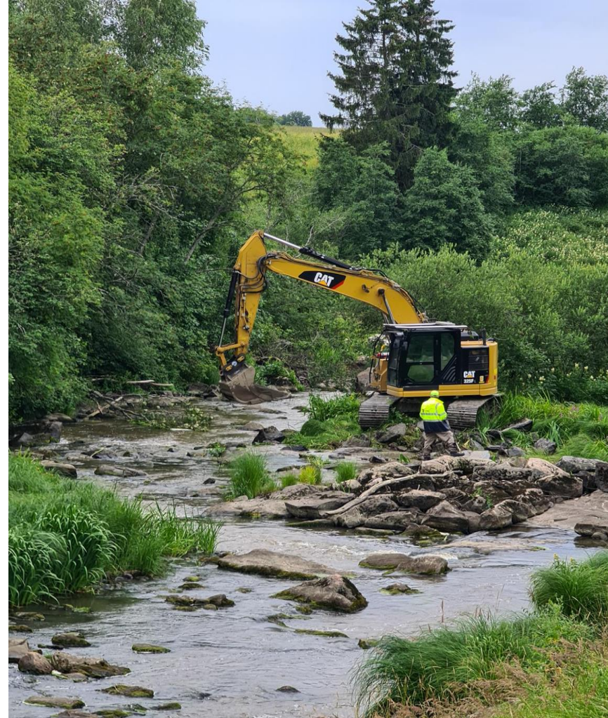
Kuva: Annelea Vuontela
